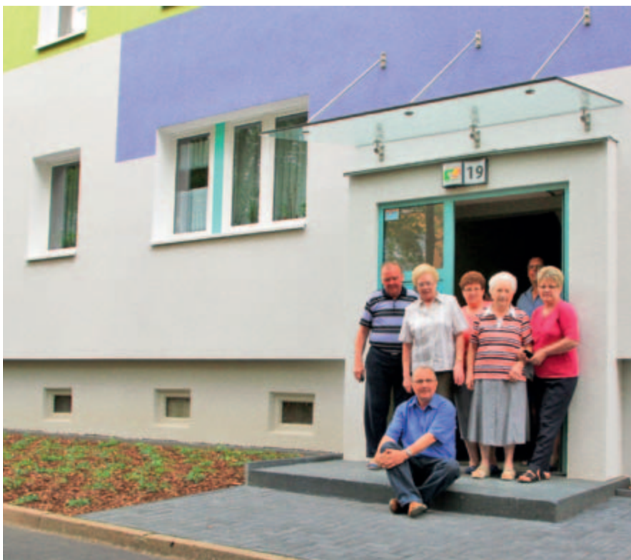
Die Mieter freuen sich über den neu gestalteten Vorgarten.
