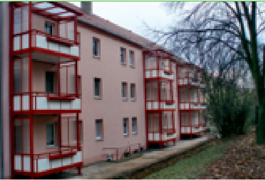
Neue Balkone in der Schillerstraße 16-20
